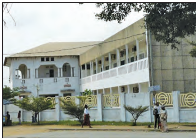
Une vue de l'hôpital Adolphe Sicé.
