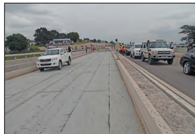
Une vue de la route de la Corniche de Baongo.
