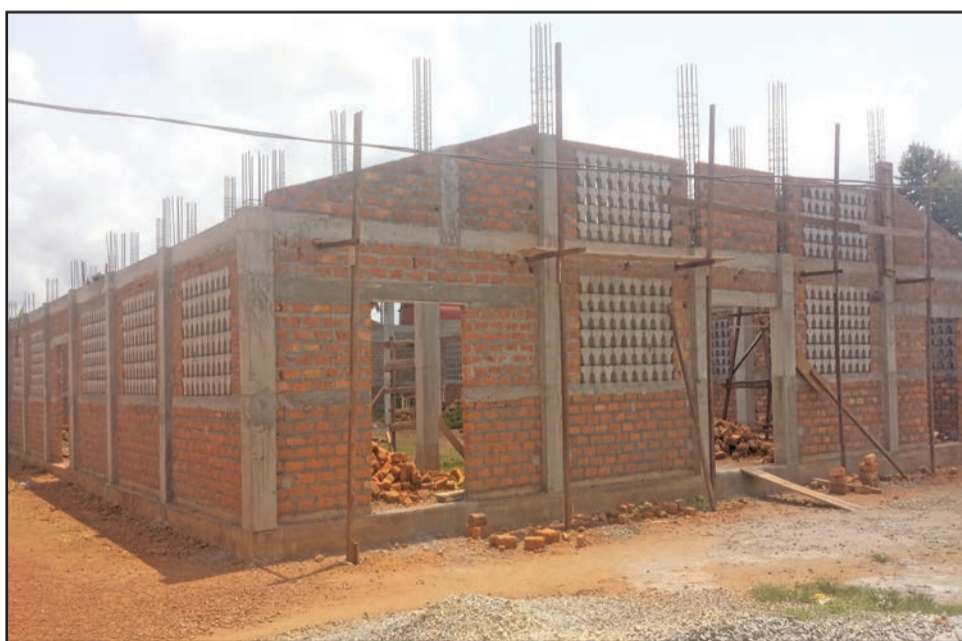
La nouvelle église en construction
