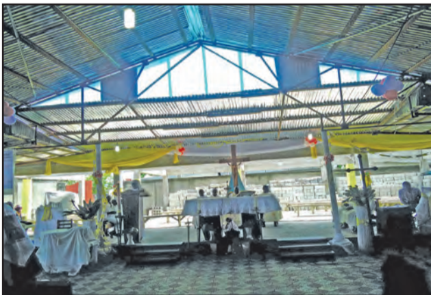
Une vue intérieure de l'église en chantier
