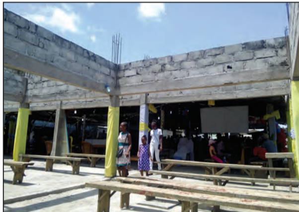
Une vue de l'église en construction (P.9)
