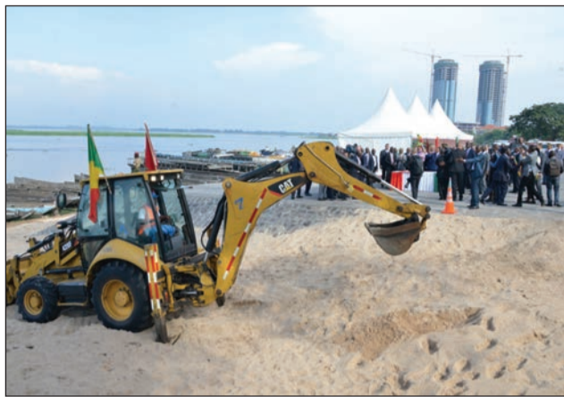
Le lancement des travaux d'aménagement du Port
