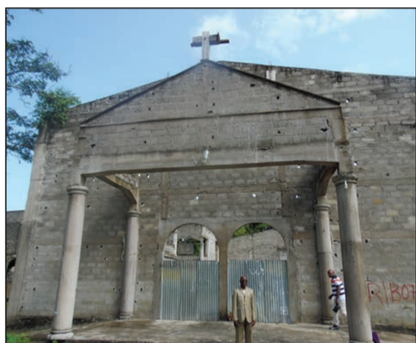
L'église en construction (P.13)
