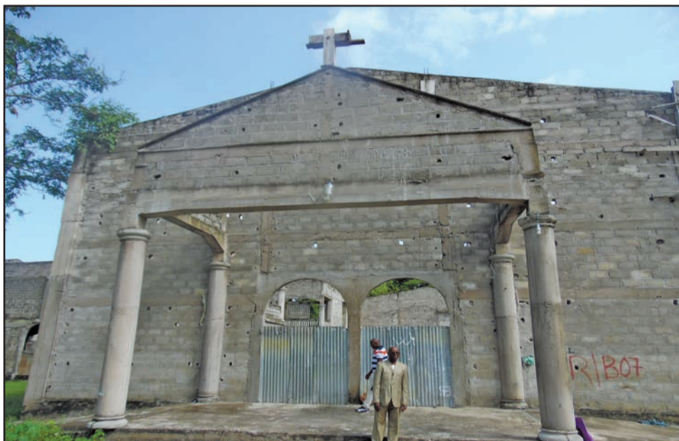
L'église en construction
