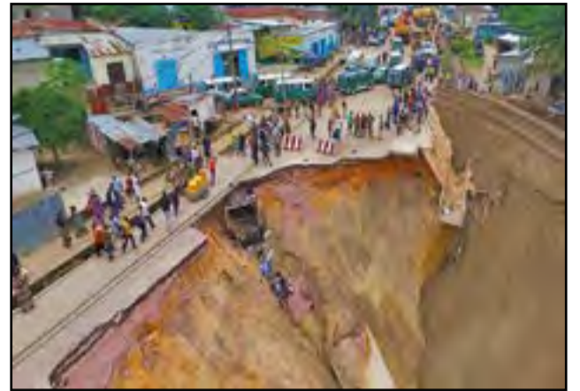
L'érosion causant plusieurs dégâts
