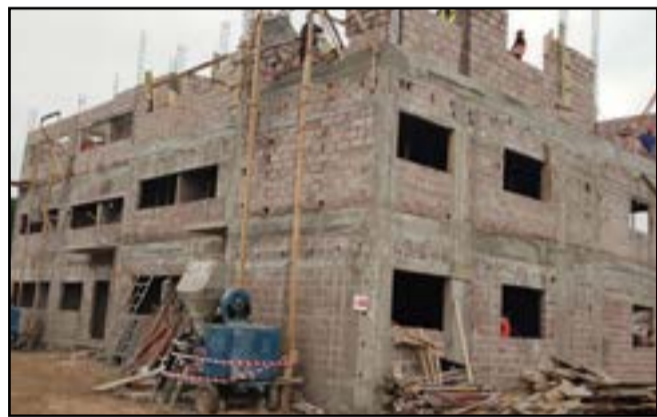
Le bâtiment en construction
