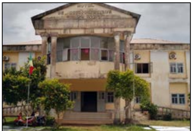
L'état de dégradation de la Sous-Préfecture de Yaya
