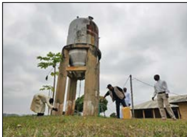
Les deux autorités visitant les installations du forage déjà fonctionnel / Photo de Amélia Banzouzi/CRS
