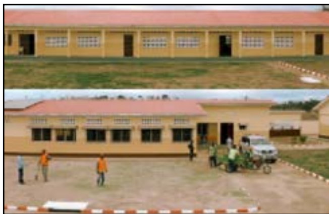
L'école réhabilitée de Tchiminzi
