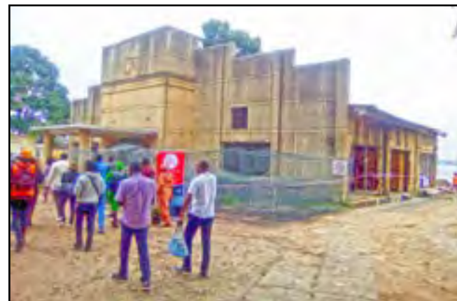
Pendant la visite du CFRAD en réhabilitation
