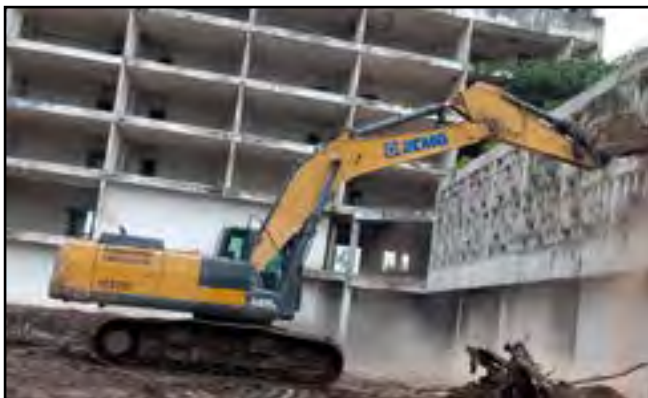
La démolition du bâtiment abritant l'ex-hôtel Cosmos
