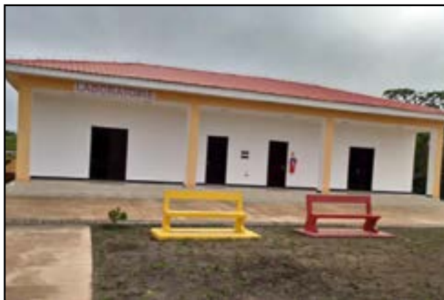
Le bâtiment abritant le laboratoire
