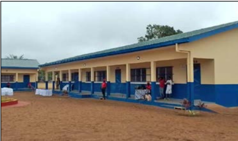
Une vue d'une partie des bâtiments rénovés
