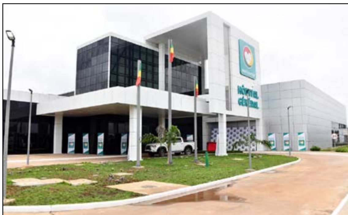
Vue partielle du bâtiment
