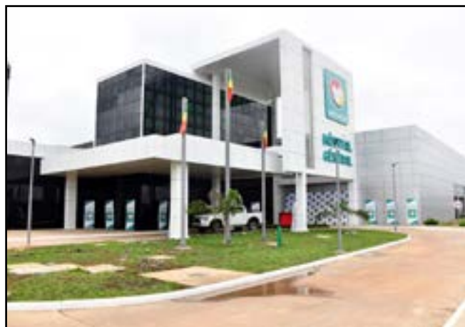
Vue partielle du bâtiment
