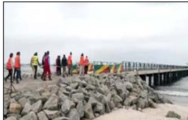
Les délégations en pleine visite du chantier
