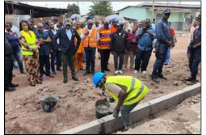
Le ministre pendant la visite des chantiers
