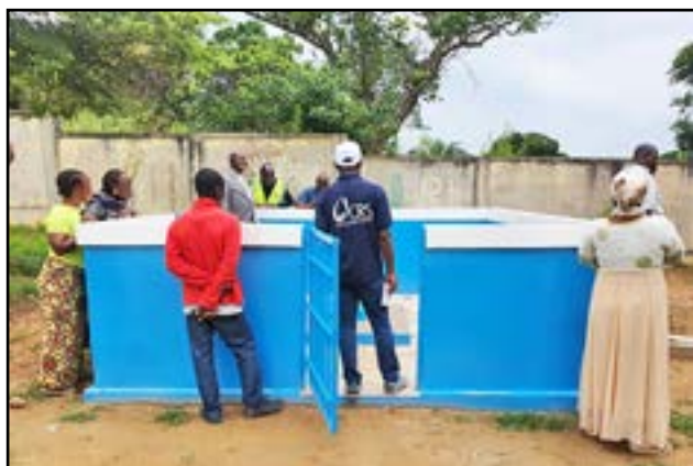
Constat d'achèvement des travaux école Victor Ndouna dans le district de Kinkala - Pool par l'équipe de supervision.
