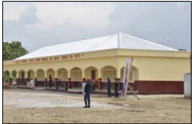
L'école de Bénè rénovée
