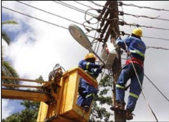
Le tripatouillage des poteaux électriques
