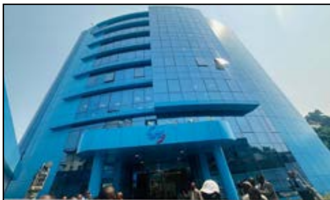
La façade principale du nouveau siège de l'ARTF
