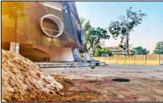
L'école en chantier
