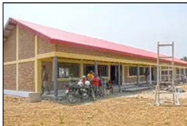
Une vue du bâtiment du lycée de Bouansa
