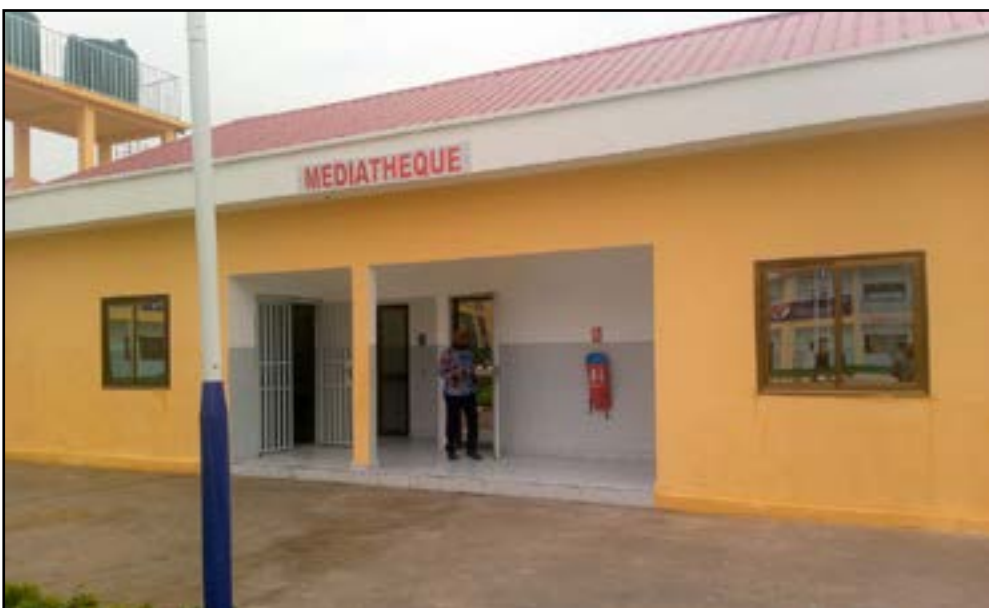
Un bâtiment plain-pied de la médiathèque
