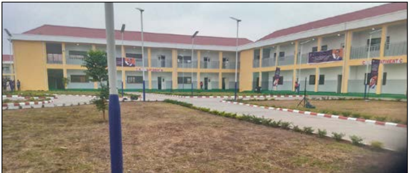
Des bâtiments en R+1 abritant les salles de classe
